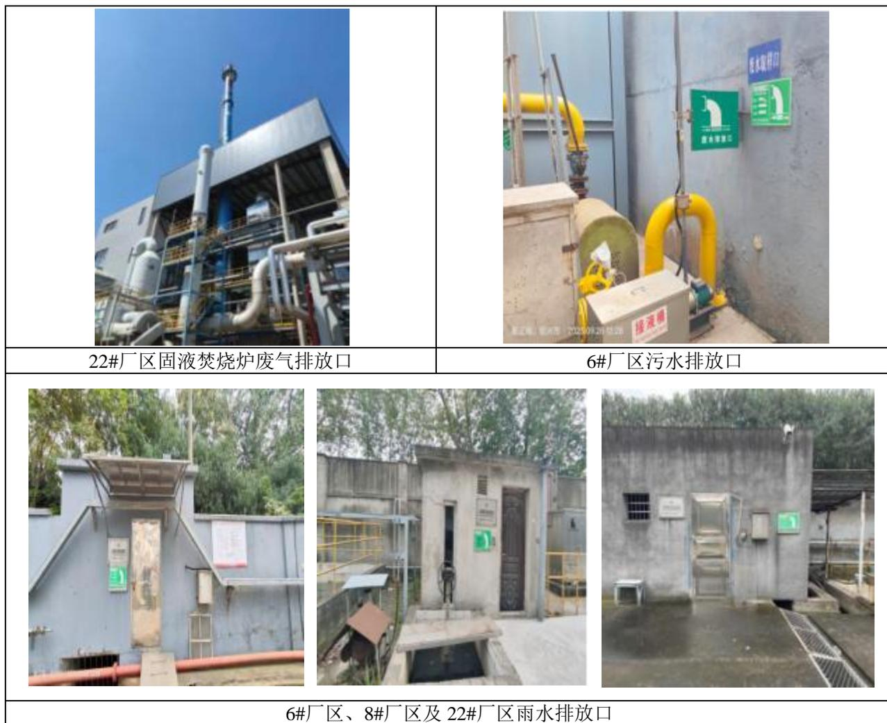
企业在 6# 厂区废水排放口及废气 RTO 焚烧装置排放口安装在线监控设施，并与环保部门联网，监测因子包括：流量、pH、COD<sub>Cr</sub>、氨氮、总氮及非甲烷总烃；22# 厂区固液焚烧炉废气排放口安装在线监控设施，并与环保部门联网，监测因子：流量、颗粒物、CO、NO<sub>x</sub>、SO<sub>2</sub>、HCl；在线监控设施相关备案文件详见附件 5。
